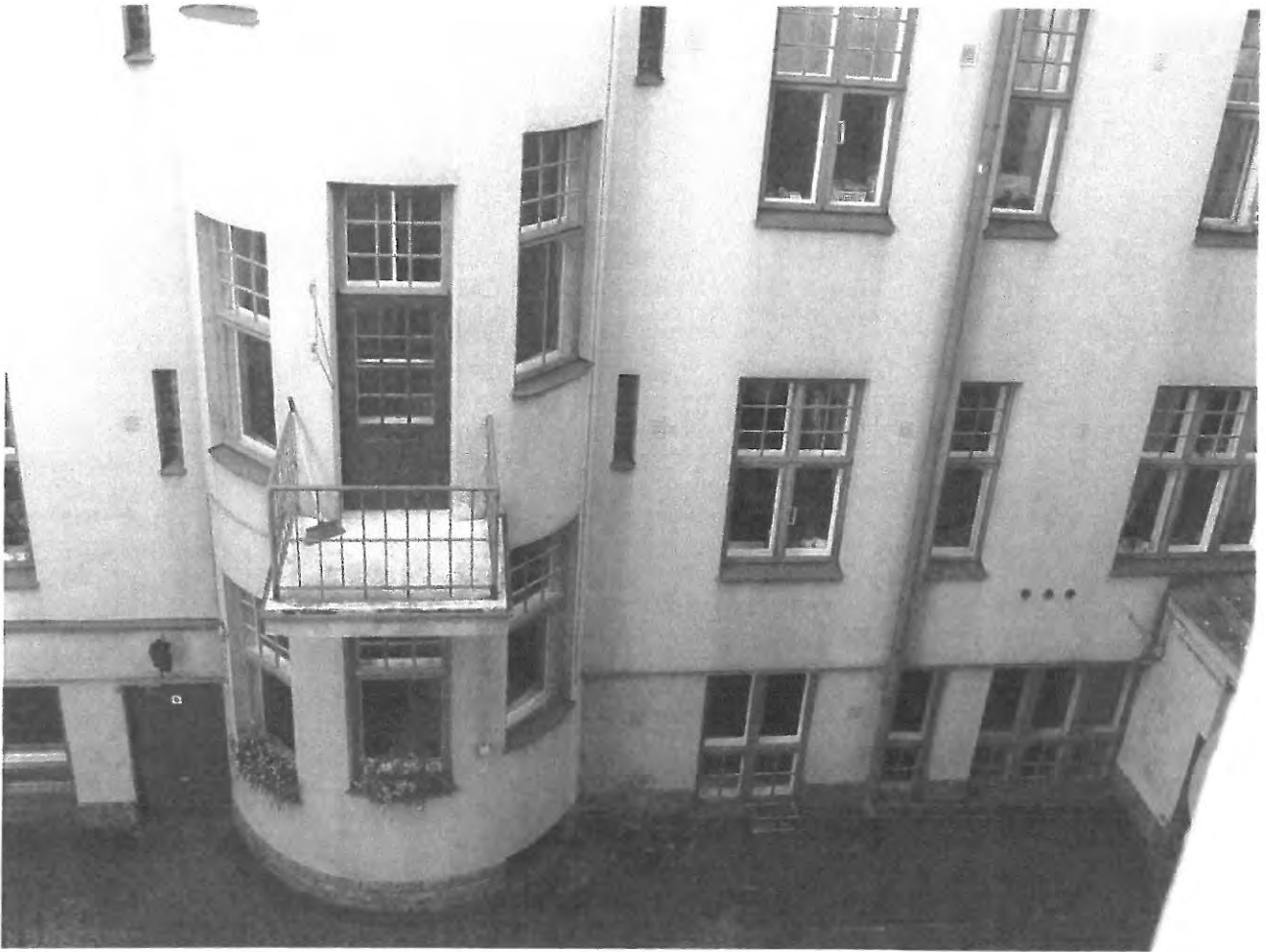
Näkymä Meritullinkatu 12 B 6:n asunnosta sisäpihalle. Kuvassa vasemmalla Meritullinkatu 12 D-rapun pyöreä torni. Yksi hissvaihtoehtoista on suunniteltu tornin oikealle puolelle sisäpihalle, jolloin oikealle jäävien ikkunoiden kautta tuleva valo asuntoihin pienehkö huomattavasti. Katso esim. ensimmäisen kerroksen maantasalla olevia ikkunoita. Ikkunat katsovat pohjoiseen.
