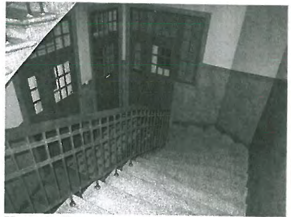
Kuva 8. C-portaan porraskuilua ja askelmia.
