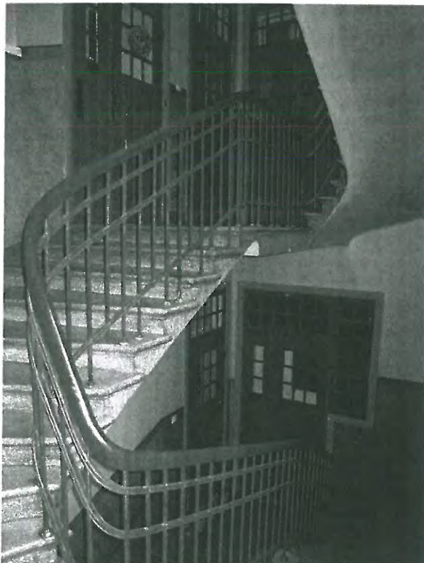
Kuva 7. C-portaan porraskuilua ja porrastasanteita.
