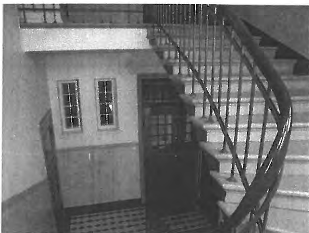
Kuva 13. D-portaan porrastasanteita ja portaikkoa.
